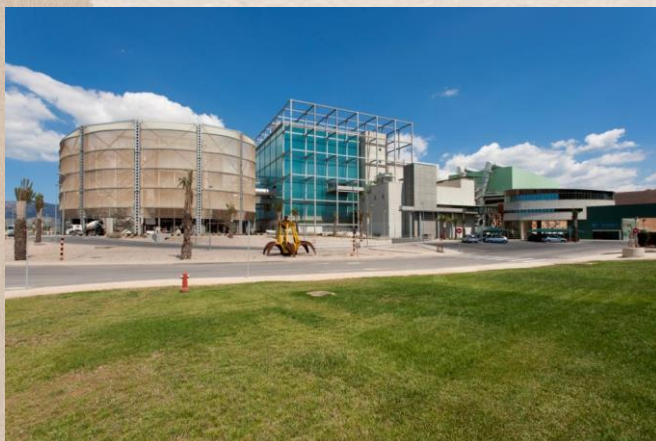
Planta de valorització energètica
